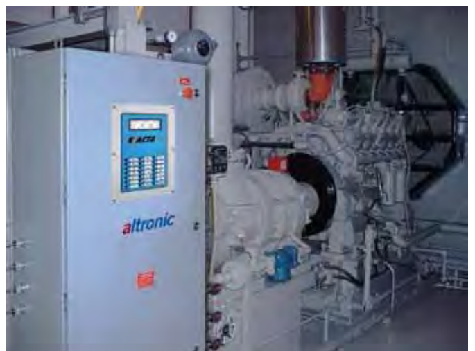
Винтовой компрессор под управлением Exacta 21
